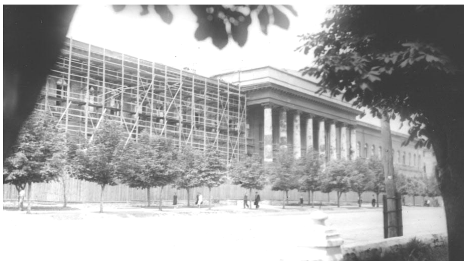
Рис. 4. Червоний корпус університету під час відбудови згідно з проектом відновлення та реконструкції, складеним у 1944-1945 рр. під керівництвом архітектора П.Ф. Альошина [8]
